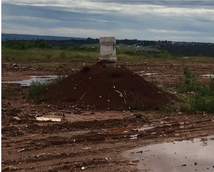
**Figura 18** - Exemplo de dreno de gases em funcionamento no Lixão da Estrutural.
