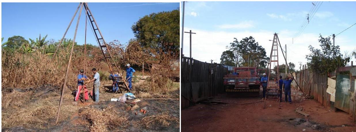
**Figura 21** - Imagens do processo de montagem e execução da sondagem tipo SPT.
