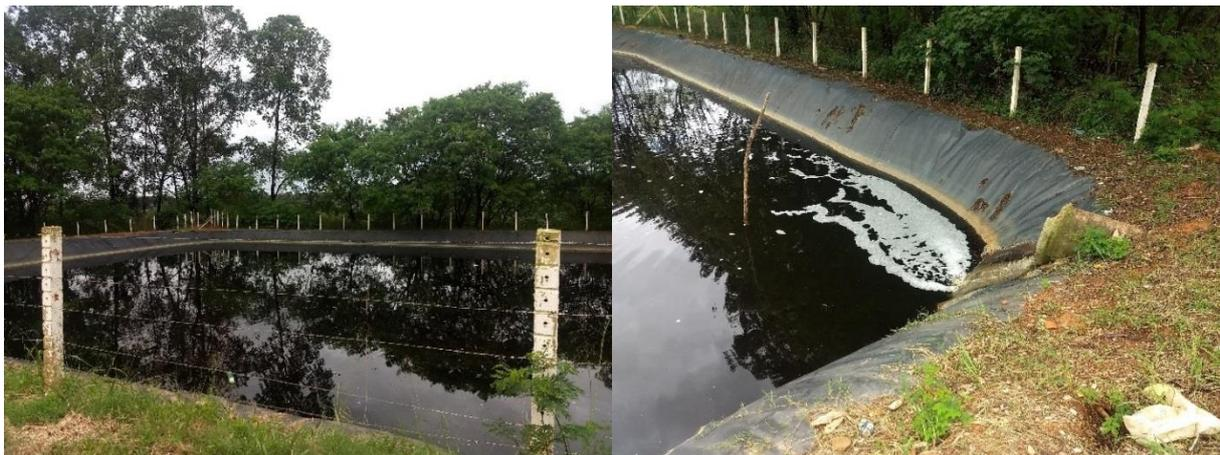
**Figura 19** - Piscina de chorume em funcionamento no Lixão da Estrutural. À esquerda, visão geral da piscina. À direita, chegada do chorume à piscina por meio de manilha e detalhe da lona de revestimento, já com porções desgastadas pela exposição.
