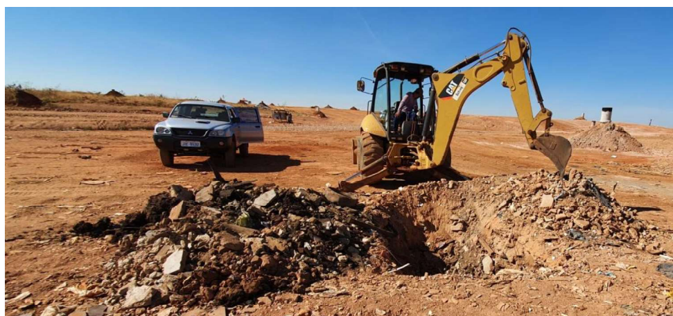
Figura 66 - Fotografia demonstrando a etapa de escavação dos pontos. O material classificado como aterro esta disposto à direita, enquanto o material analisado ocorre ao lado esquerdo da escavadeira.
