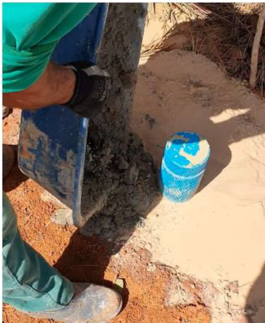
Figura 61 - Etapa de concretização do poço com o auxílio de masseira para melhor distribuição do concreto e preservação da área do Parque Nacional.
