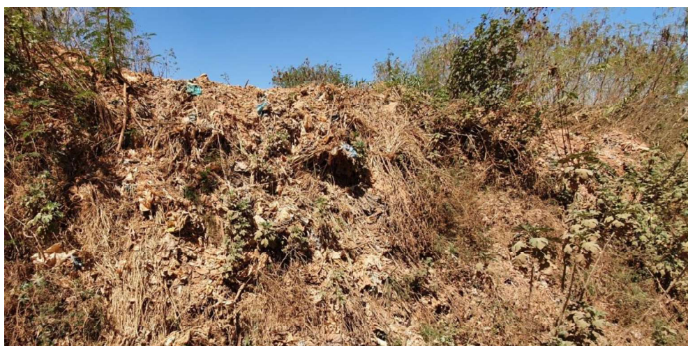
Figura 76 - Fotografia mostrando corte de talude e disposição do material na porção oeste mais antiga do aterro.
