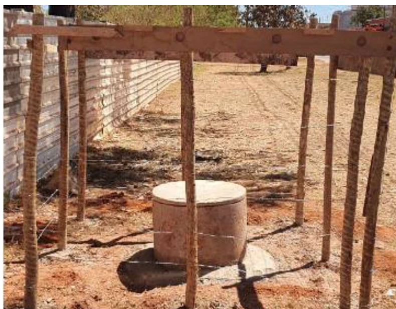
Figura 63 - Os poços localizados na área urbana também foram cercados com fios de arame farpado.
