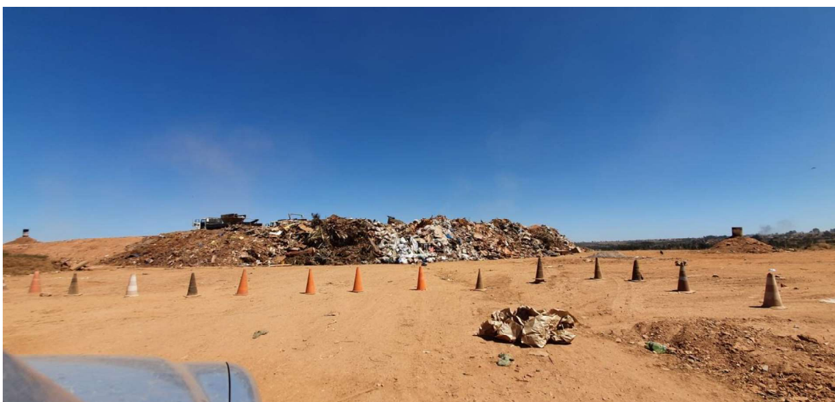
Figura 78 - Fotografia tirada perto do ponto GRA-01 que mostra o exato momento da colocação do material no aterro, o que corrobora com o observado no ponto GRQ-03
