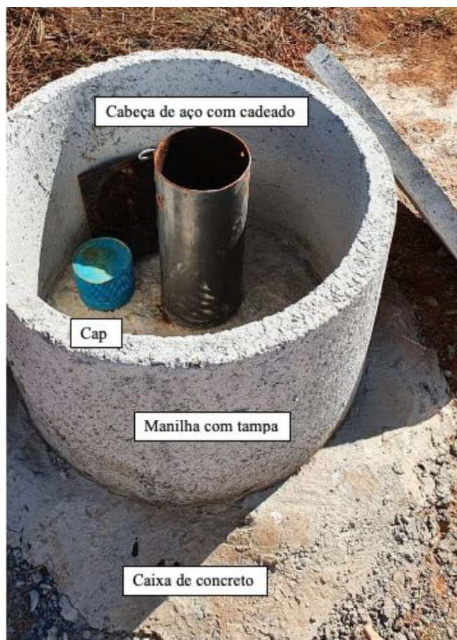
Figura 62 - Todos os poços contam com ao menos 3 proteções: Cap, cabeça de ferro com cadeado e manilha com tampa.
