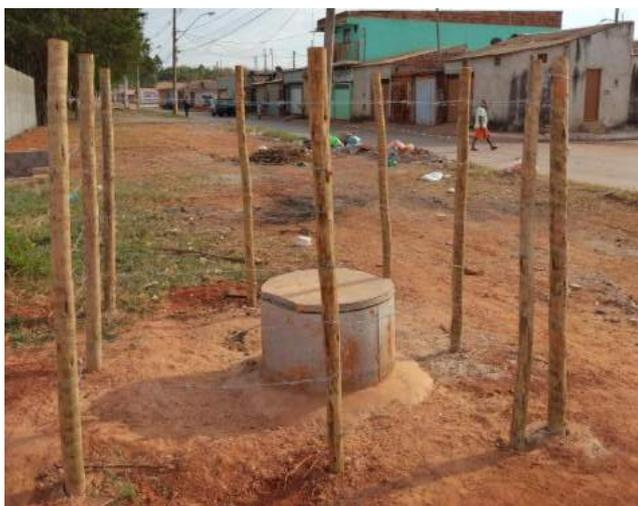
**Figura 34** - Cerca de proteção de poços instalados na área urbana da Cidade Estrutural.
