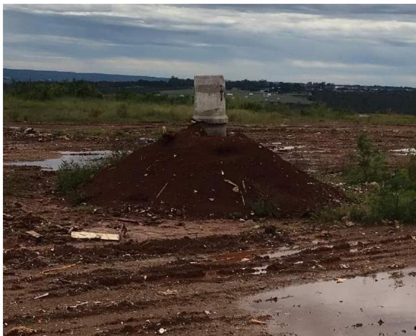
**Figura 17** - Exemplo de dreno de gases em funcionamento no Lixão da Estrutural.
