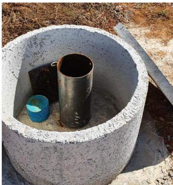
**Figura 33** - Sistema de proteção triplo, composto por *cap* de PVC rosqueável, tubo de aço carbono com tampa e cadeado e manilha em concreto com tampa.
