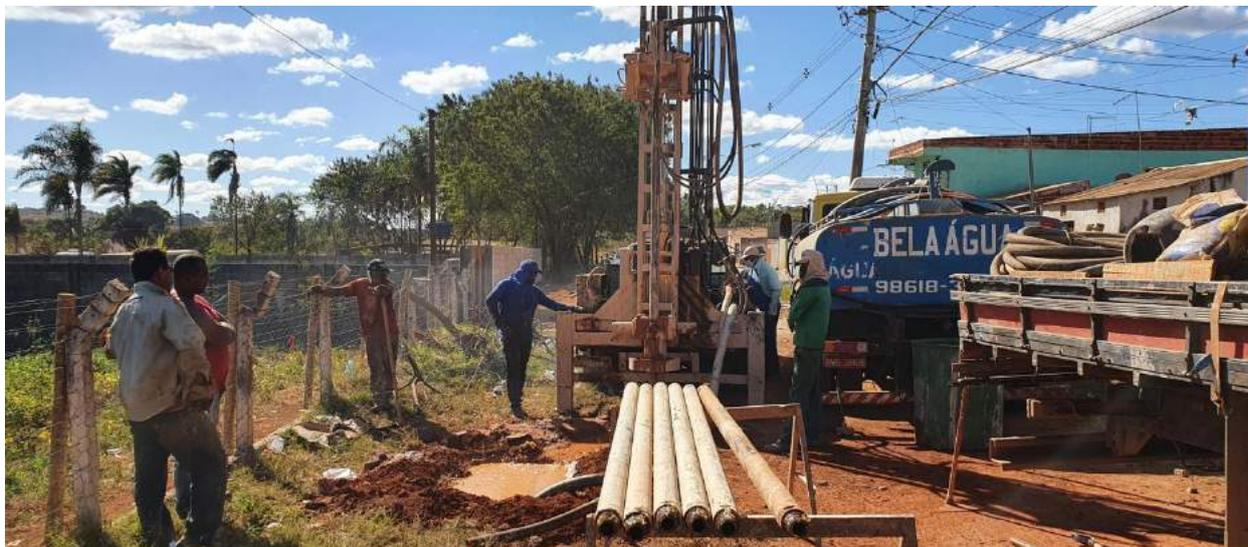
**Figura 29** - Perfuração do poço LX14, mostrando a torre com sistema hidráulico, as hastas metálicas e a caixa de circulação de lama. O caminhão pipa situado ao lado da torre do sistema hidráulica fornece água para circulação no interior do conduto.
