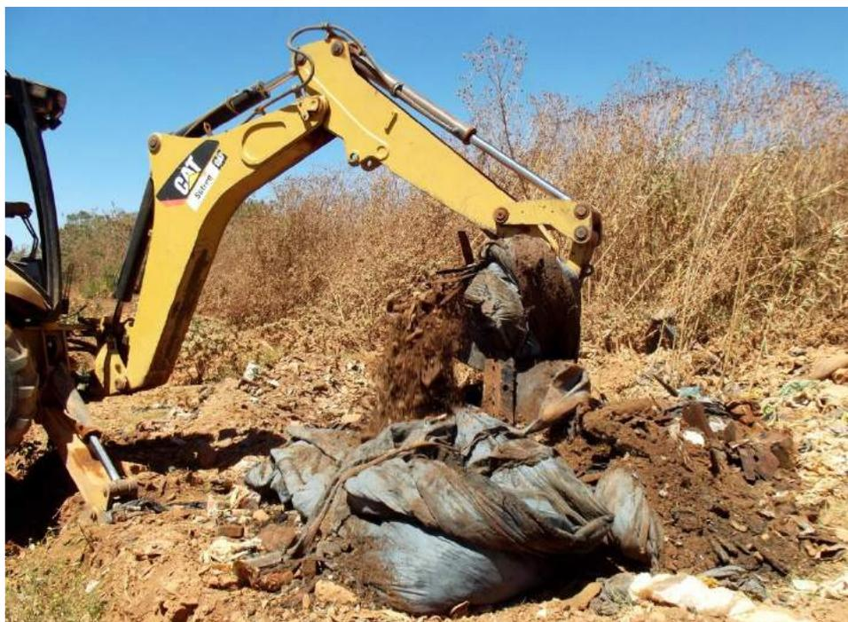
**Figura 59** - Abertura da trincheira GRA - 06 com a retirada e homogeneização dos resíduos. Detalhe para o tecido Geotêxtil retirado
