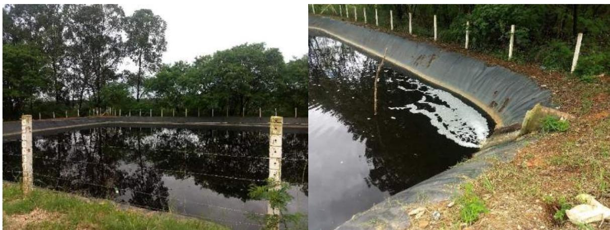
**Figura 18** - Piscina de chorume em funcionamento no Lixão da Estrutural. À esquerda, visão geral da piscina. À direita, chegada do chorume à piscina por meio de manilha e detalhe da lona de revestimento, já com porções desgastadas pela exposição.
