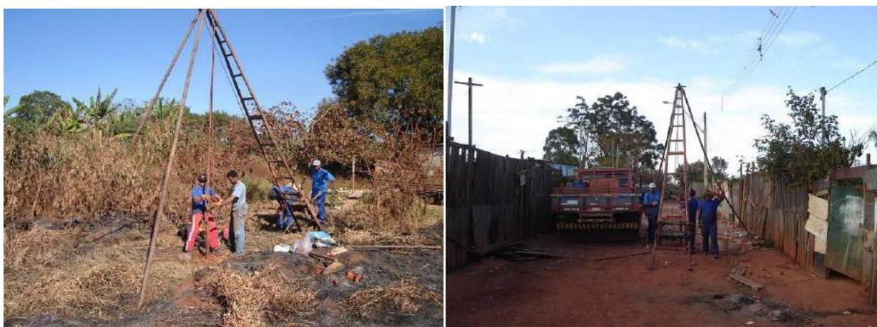
**Figura 20** - Imagens do processo de montagem e execução da sondagem tipo SPT.
