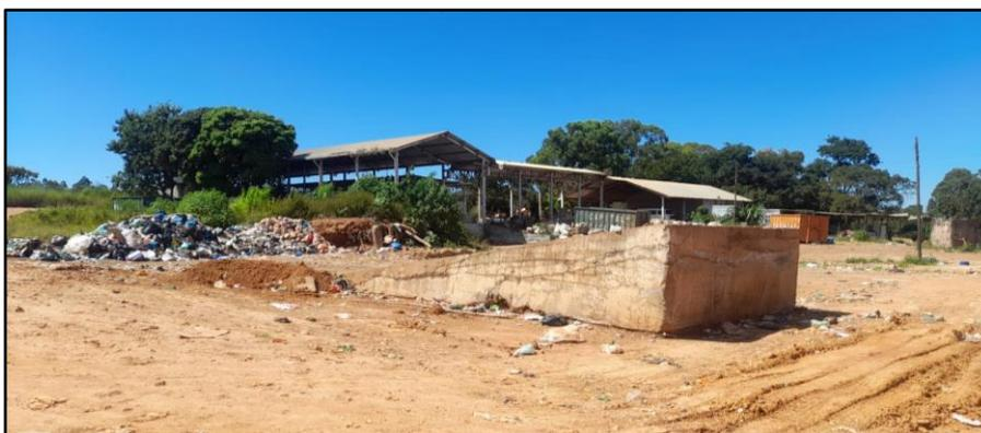
Figura 30: Rampa situada na área de transbordo, usada pela pá carregadeira para carregamento dos resíduos na carreta.
