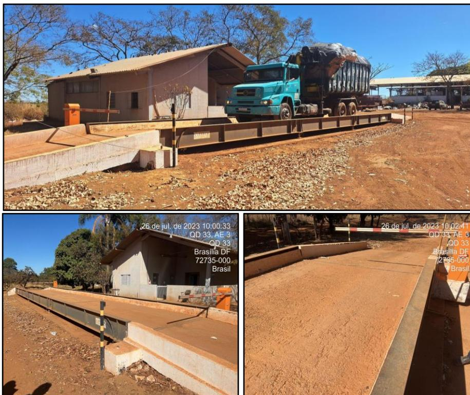
Figura 28: Pesagem de caminhão (acima); balança e pavimentação da balança (abaixo).
