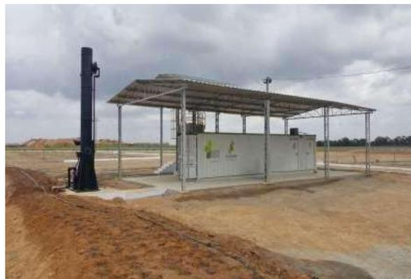
*Figura 1 - Sistema de OR para tratamento de chorume em operação na Alagoas Ambiental.*
