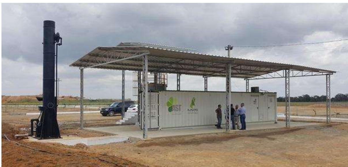
Figura 15 – Lavador de gases, Sistema de OR em três etapas para uma vazão de 200 m<sup>3</sup>/d, Alagoas, Brasil.
