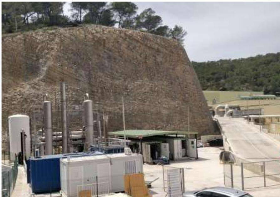
*Figura 2 - Sistema de OR para tratamento de chorume e com OR para concentrado e evaporação, capacidade 250m<sup>3</sup>/dia Ibiza (Espanha).*
