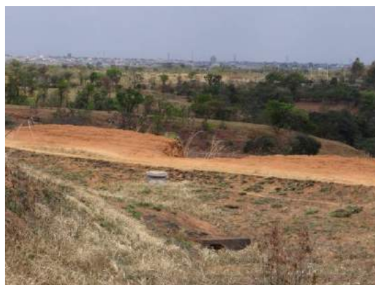
Figura 60 - Dique erguido nas cabeceiras do Córrego do Valo.
