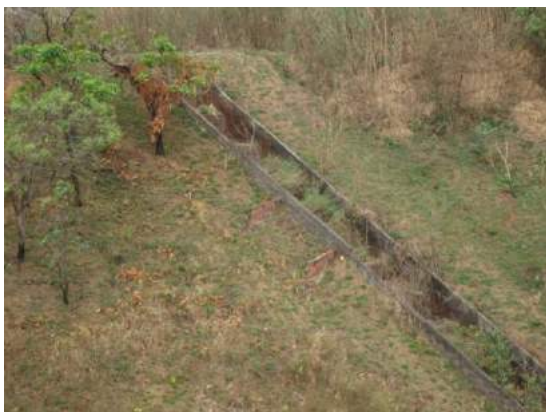
Figura 105 – Descida d'água em escada.
