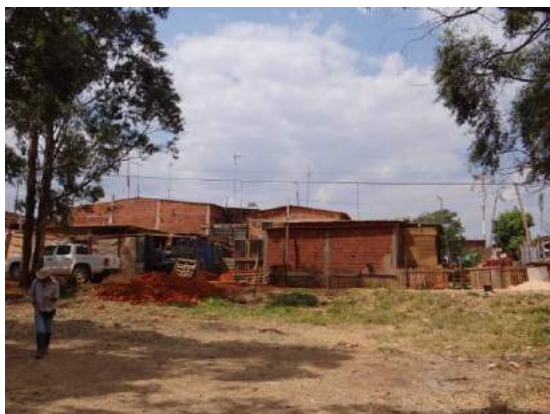
Figura 61 - Edificações em APP do córrego Grotão.
