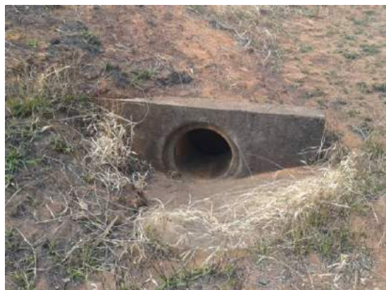
Figura 91 - Entrada da rede de água pluvial.
