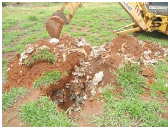
Figura 160 - Lixo soterrado na área 2. Coordenadas SICAD – Sirgas 2000/E- 164634.2922/ N-8245879.7925.
