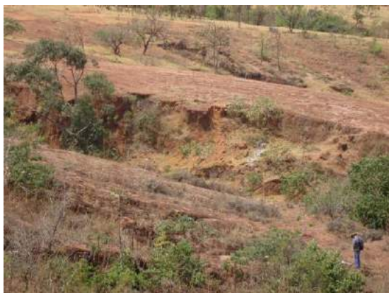
Figura 144 - Aspecto da área 1 no entorno das erosões, onde foi realizada a suavização de taludes.
