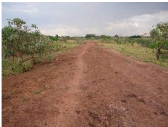
Figura 73 - Terraço para contenção de águas pluviais.
