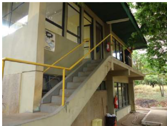
Figura 130 – Prédio administrativo da UILE.
