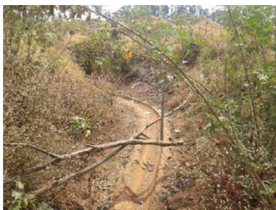
Figura 98 – Canaleta de água pluvial originada da UCTL – Ponto 1.
