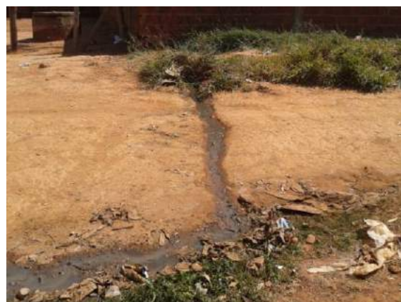
Figura 101 - Esgoto oriundo das residências às margens do córrego Grotão.
