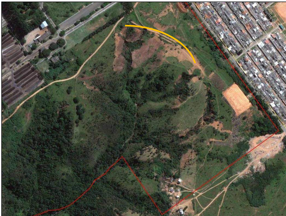
Figura 122 – Cabeceira do córrego do Valo com detalhe ao terraceamento executado no intuito de redirecionar as águas pluviais para fora das erosões instaladas.
