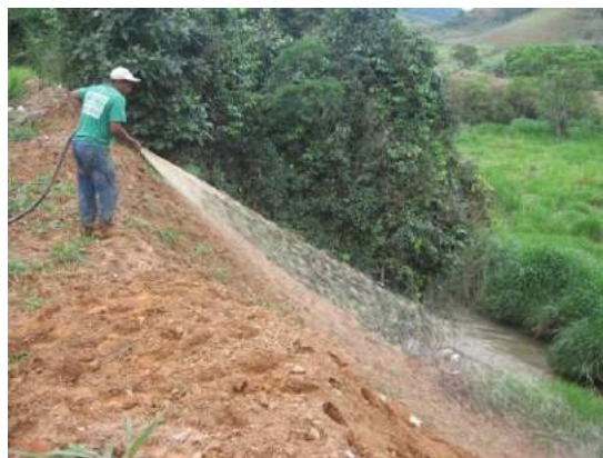
Figura 157 – Ilustração do jateamento da solução de sementes e fertilizantes em talude marginal de um rio.
