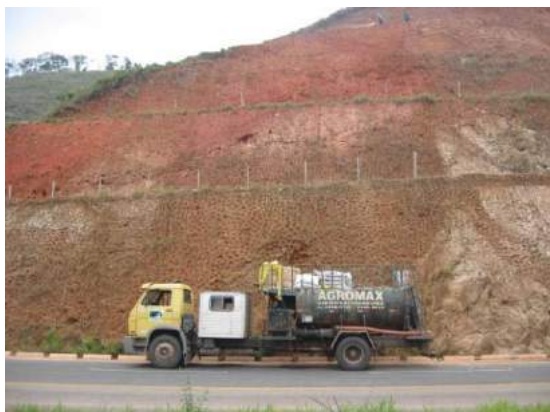
Figura 156 - A foto demonstra um caminhão de hidrosemeadura utilizado para realizar a proteção vegetal em talude de corte em uma obra rodoviária.
