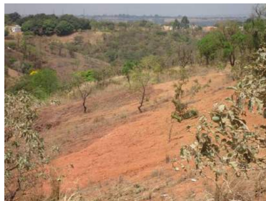
Figura 145 - Talude suavizado evidenciando substrato rochoso que dificulta o estabelecimento vegetal.
