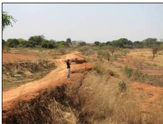
Figura 123 - Vista do terraceamento a montante das erosões no córrego do Valo.
