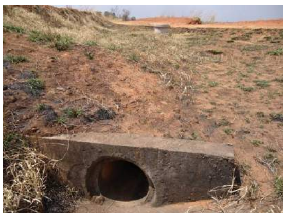
Figura 59 - Bueiro de entrada instalado em bacias de captação de águas pluviais.
