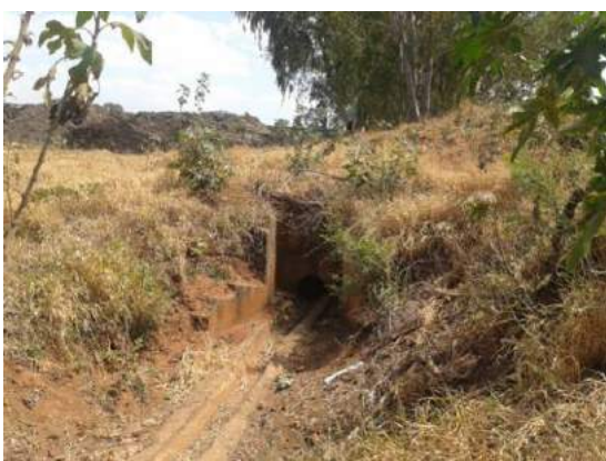
Figura 97 – Saída de água pluvial da UCTL – Ponto 1.
