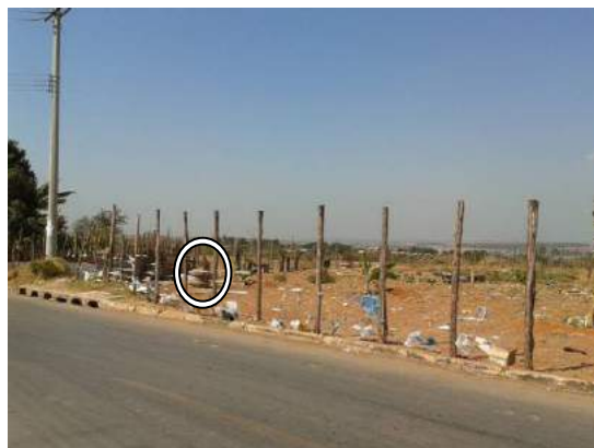
Figura 94 – Poço de visita da rede de esgoto.
