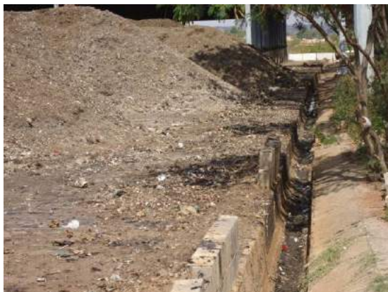
Figura 69 - Canaleta para captação de chorume ao lado da pilha de composto.
