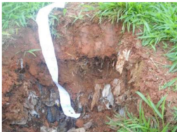
Figura 34 - Área 5 – Perfil de solo 19: 0 a 35 cm de solo; 35 cm a 1,12 m de lixo. Coordenada SICAD – Sirgas 2000
