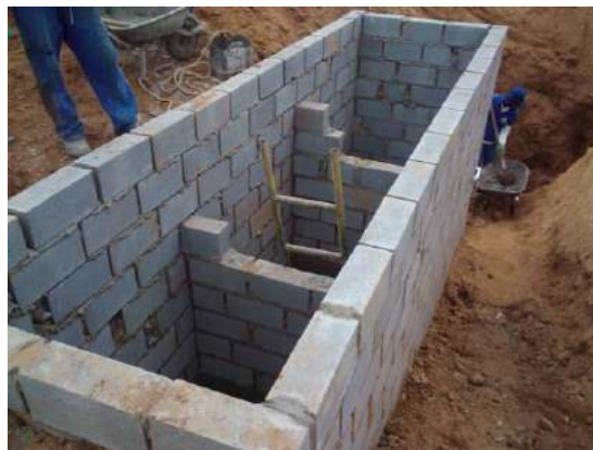
Figura 72 - Execução do sistema de tratamento do efluente.
