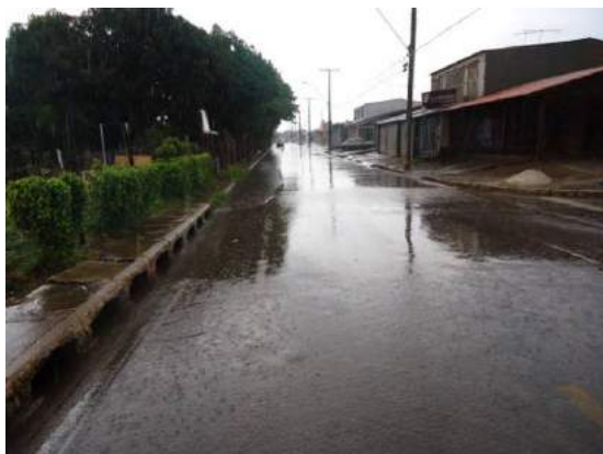
Figura 57 - Aspecto da Via P-5 durante uma chuva.
