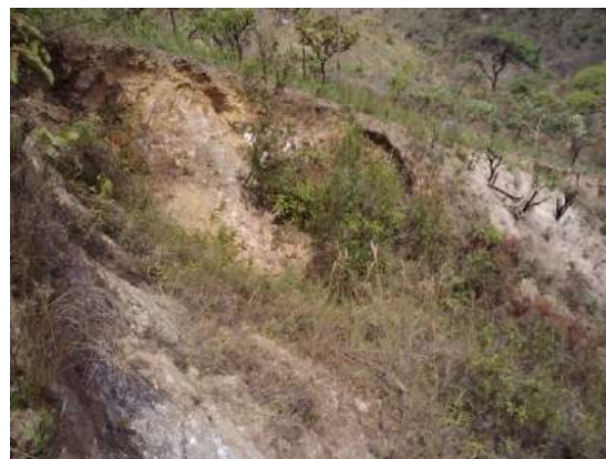
Figura 78 - Voçoroca em aflente do Córrego do Valo.
