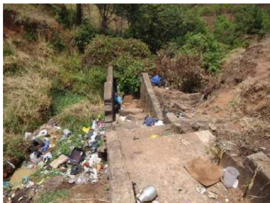
Figura 104 - Dissipador de energia inutilizado
