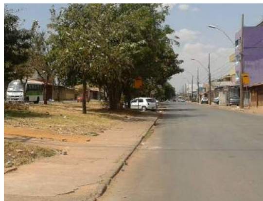
Figura 90 - Boca de lobo da rede de drenagem da EQNP 28.
