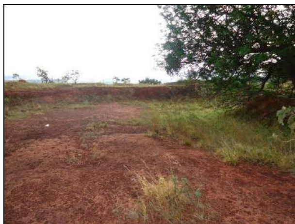
Figura 126 – Detalhe do terraceamento executado próximo à quebra de vertente do córrego do Valo – lado direito.
