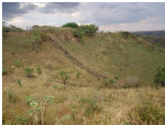
Figura 74 - Descida d'água em escada na borda da chapada.
