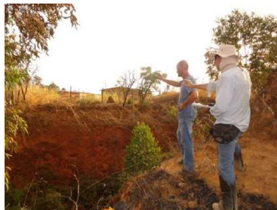
Figura 62 - Edificações nas proximidades de voçoroca.
