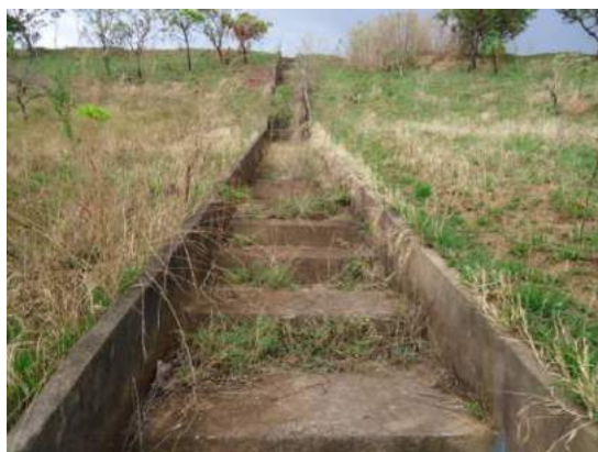
Figura 99 - Detalhe descida d'água em escada.
