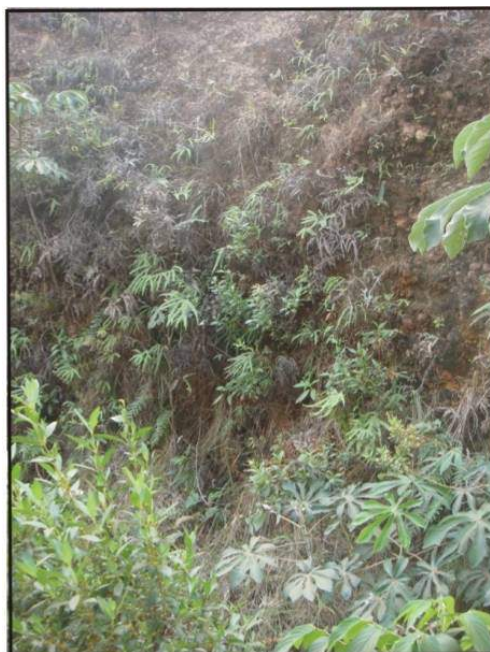
Figura 82 – Vegetação instalada nas paredes das erosões.
