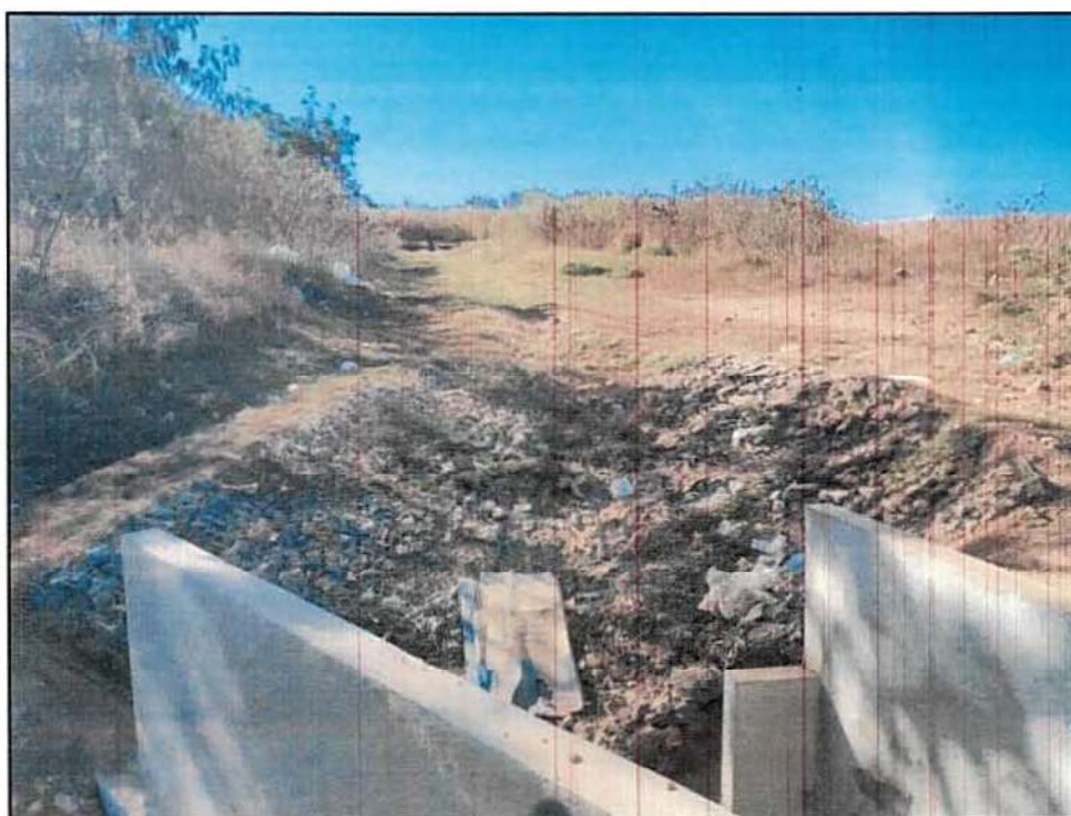
Figura 5 – Gabião à Noroeste do Platô.
