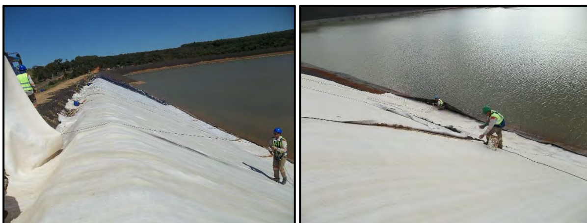
Figura 05: Instalação de Barreira Geossintética - GCL
