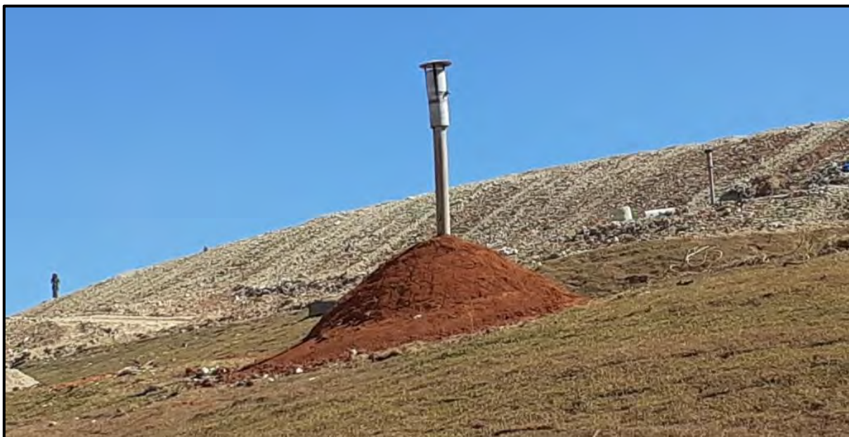
Figura 03: Dispositivo de queima do biogás (Flare) do ASB(Samambaia-DF).
