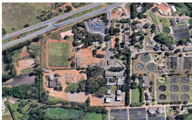
Figura 1: Núcleo de Limpeza de Brasília - Asa Sul
